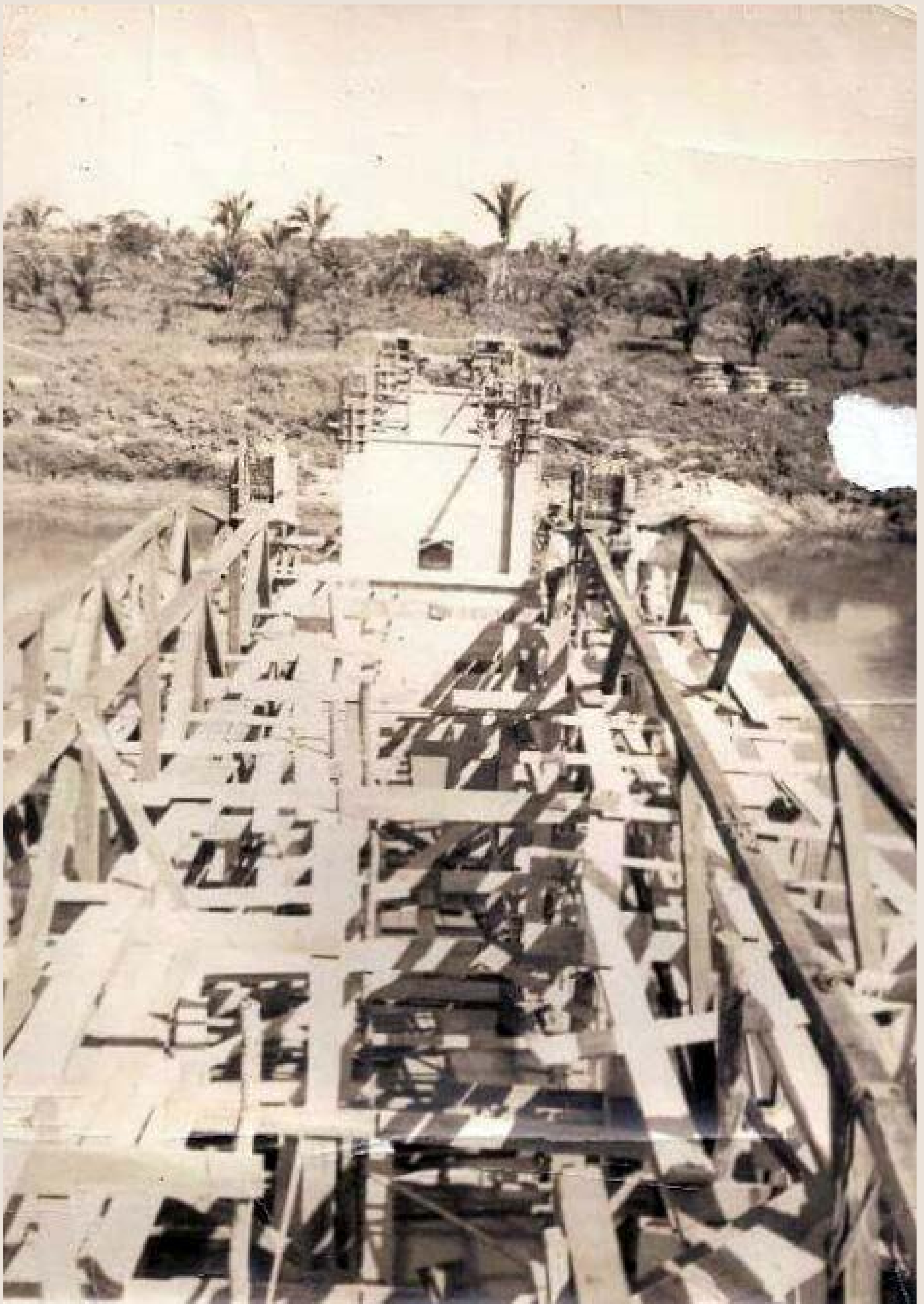
TRAVESSIA: 1958: obra de construção da ponte sobre o rio Araguaia
